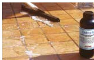
Diluire il detergente acido **DETERG-A** con una quantità di acqua proporzionata alla rilevanza delle impurità e concrezioni presenti sulla superficie. Versare la soluzione sulla superficie, distribuendola al meglio con uno spazzolone tira-liquidi. Attendere 15 minuti per la reazione acida, schiumosa. Lavare con acqua abbondante.
