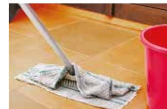
Dopo un'ora dalla stesura, rimuovere con uno straccio imbevibile di diluente nitro eventuali residui e ristagni di prodotto rimasti sulla superficie della pavimentazione. L'impermeabilizzazione trasparente non pellicolare ad alto potere idrorepellente sarà così completa.
